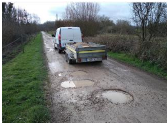
Figure 17. Bouchage des trous sur le chemin du Râle (hiver 2024-25)
