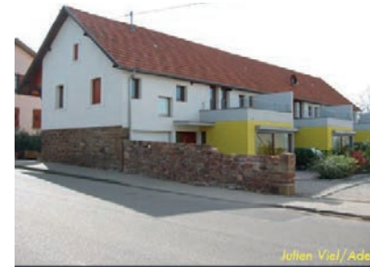
Photos : Julien Viel/ Adeus Grange rénovée, Alsace
