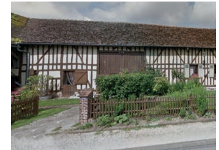
Longère rénovée, Géraudot
