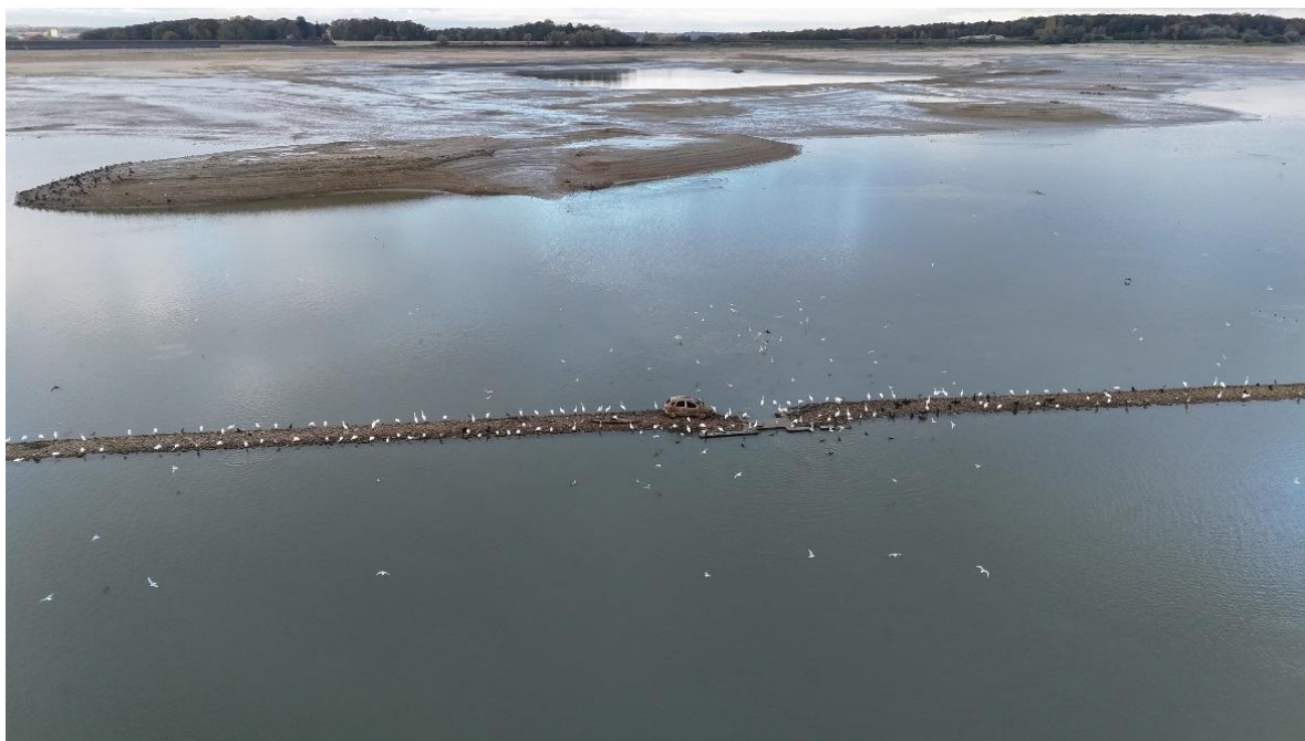
Figure 4. Digue de l'étang de la Morge des champs (Mesnil St Père), vidange 2025 (Drone SG).
