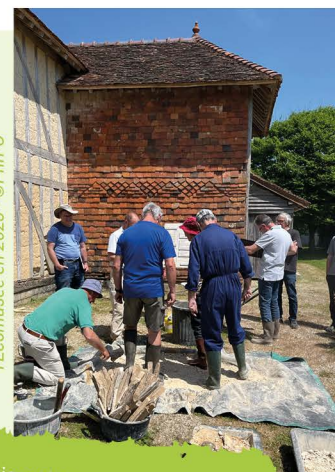
Atelier de rénovation du torchis à l'Écomusée en 2023 - ©PnrFO
